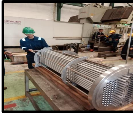
Gambar 3. Proses pemasangan Tube ke Tubesheet
