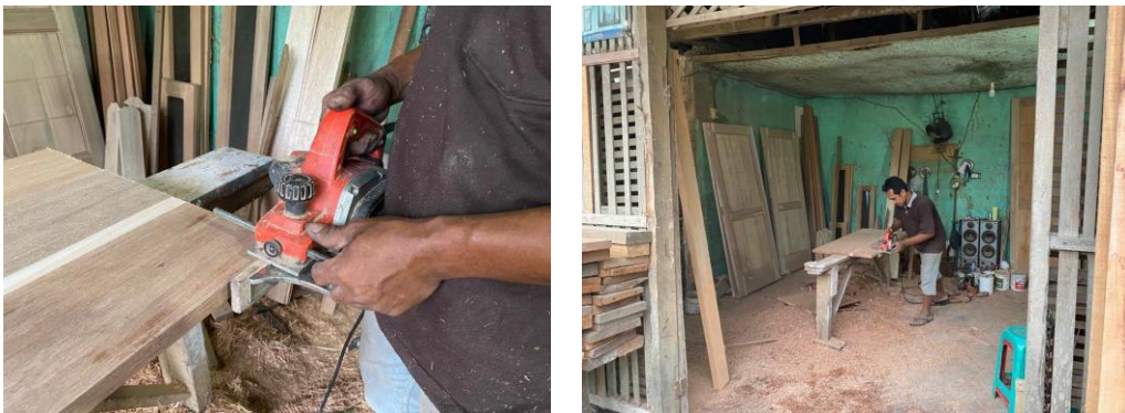
Gambar 1. Proses Pembuatan Kusen Pintu
