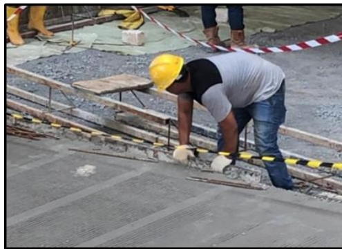
Gambar 9. Pembongkaran Bekisting Pelat Ramp
