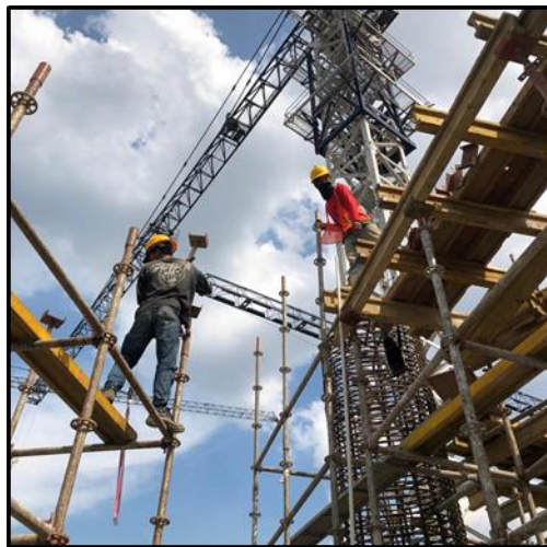
Gambar 3. Pemasangan Scaffolding Pelat Ramp
