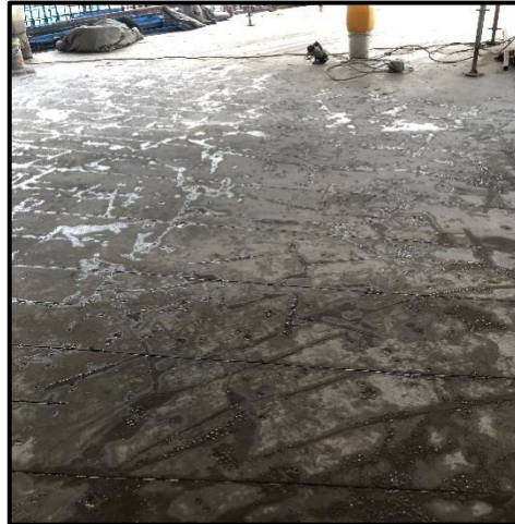
Gambar 8. Curing pada Pelat Ramp
