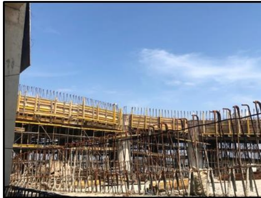
Gambar 6. Pemasangan Bekisting Pelat Ramp
