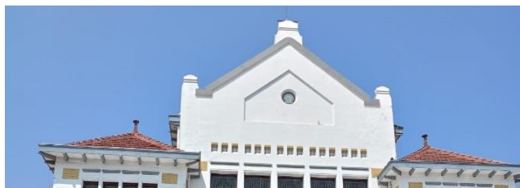
Gambar 9. Mahkota pada bagian atap bangunan stasiun yang terlihat dari tampak depan Sumber: Dokumentasi lapangan, 2024
