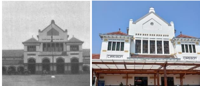
Gambar 13. Perubahan elemen fasad bangunan sejak dibangun tahun 1911 dan saat ini Sumber: Spoorwegstation op Java_ M.V.B de Jong; Laksana et al., 2016 (kiri) Dokumentasi Lapangan, 2024 (kanan).
