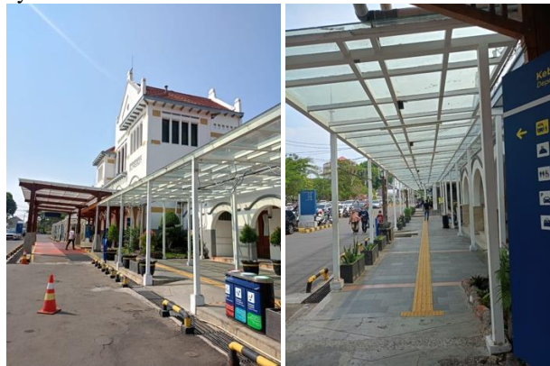
Gambar 16. Penambahan kanopi sebagai naungan di bagian main entrance dan depan bangunan dari arah jalan.
