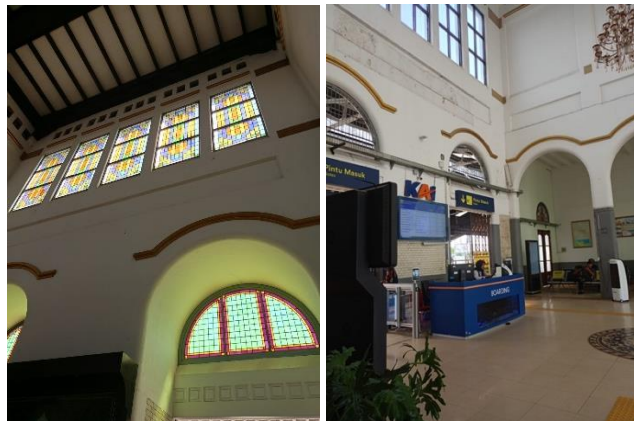
Gambar 11. Elemen kaca patri warna-warni pada bovenlicht. Sumber: Dokumentasi lapangan, 2024
