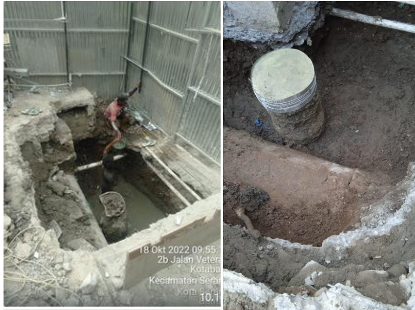
Gambar 15. Pengerjaan Pilecap
