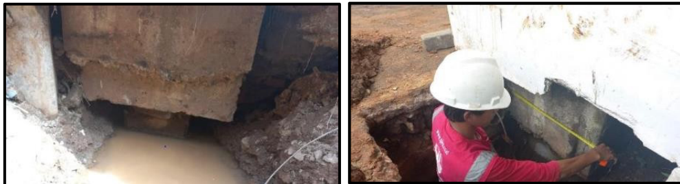
Gambar 4. Pekerjaan Galian Pondasi
