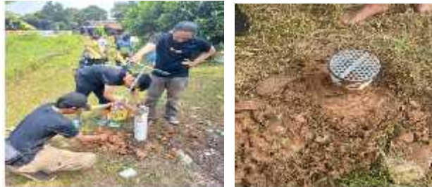
Gambar 2. Kegiatan pembuatan Biopori
